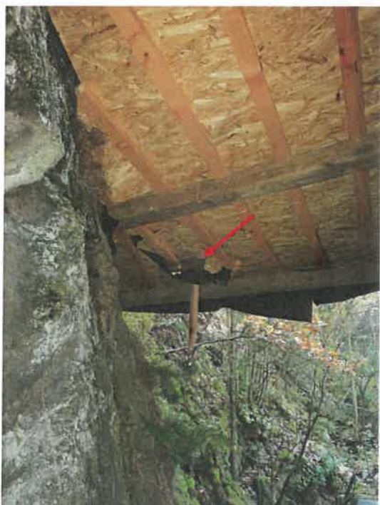
Obr.3 – poškozené zastřešení po pádu bloku
