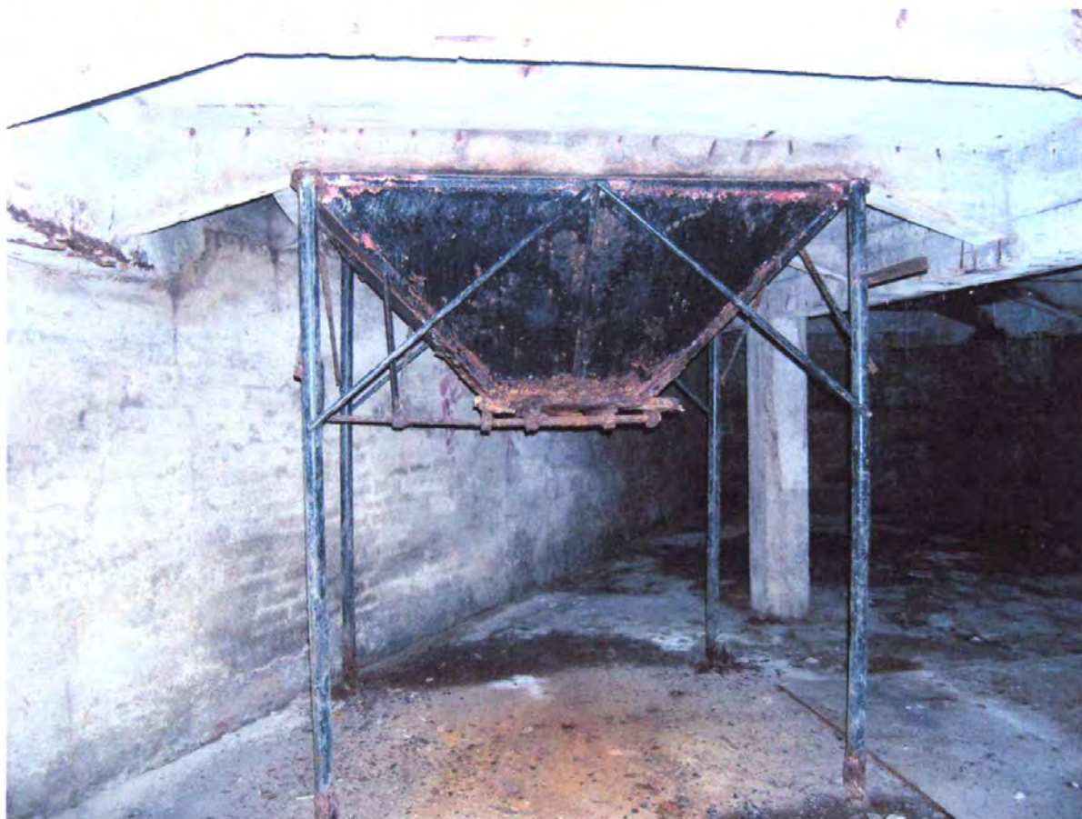
Koroze nosných konstrukcí stropu:
