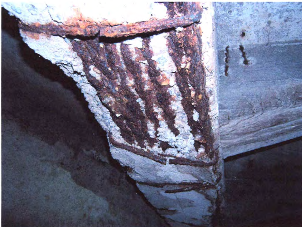
Koroze nosných konstrukcí stropu:
