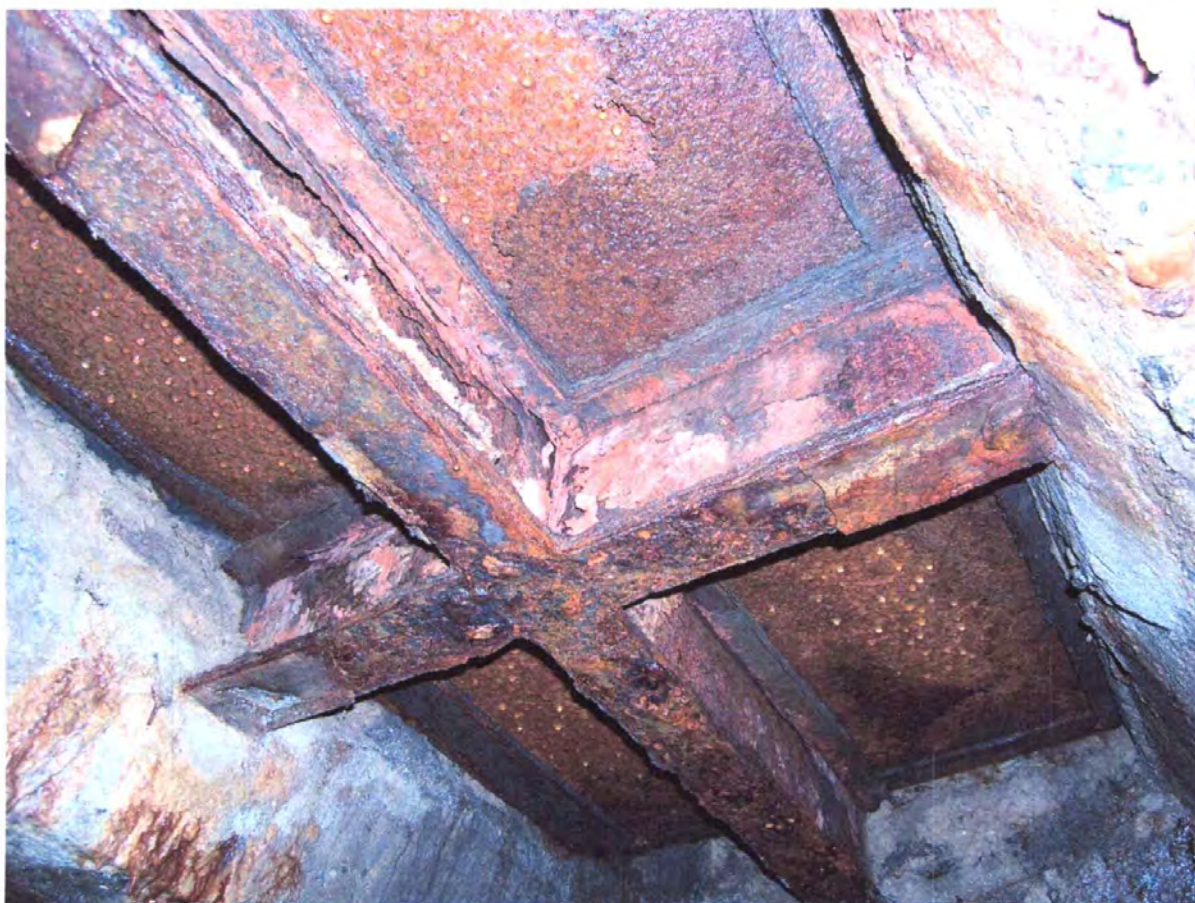
Nosné ocelové válcované profily - otvory nad násypkami:
