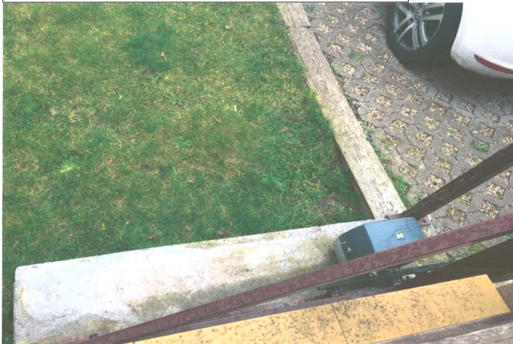
Detail betonového základu s umístěním pojezdového mechanismu
