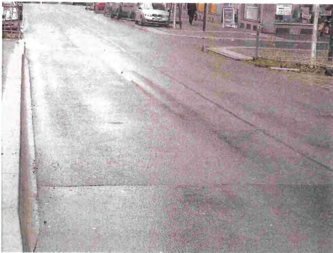
Obrázek 13 – ul. Prokopa Holého – podélné koleje u autobusové zastávky
